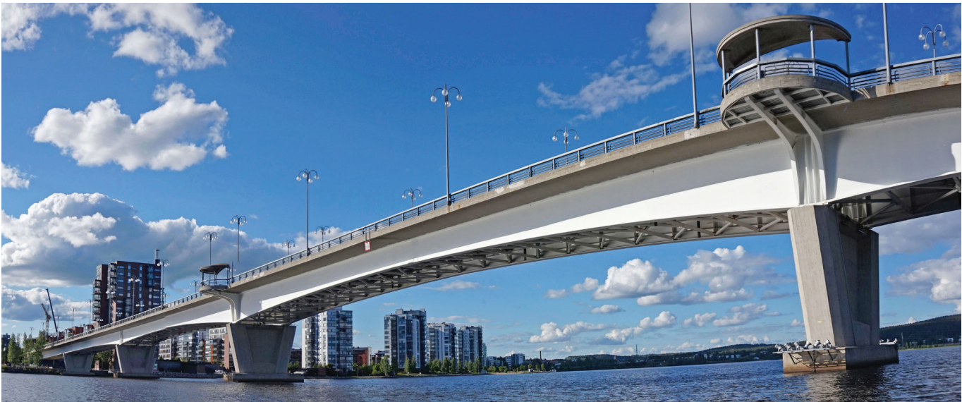
Kuokkala Bridge, Jyväskylä
